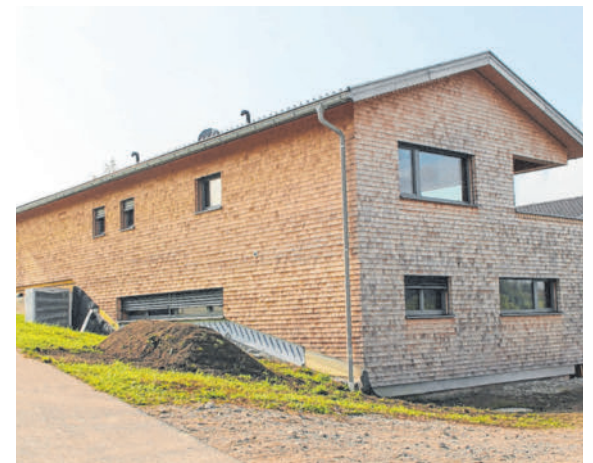
Eines der Beispiele der Aktion „kumm ga luaga“ – Sohm Holzbau in Alberschwende erstellte dieses Einfamilienhaus in Hohenweiler.
